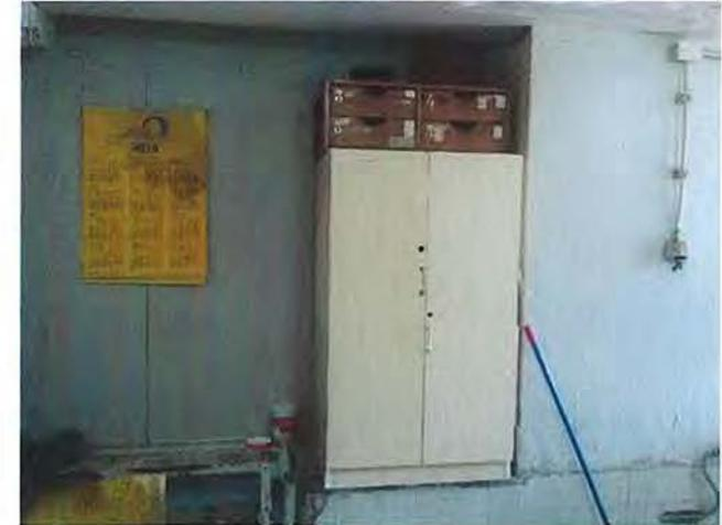
Fotografía N°18: Bodega de residuos especiales. Sin ventilación ni paredes de material lavable.
